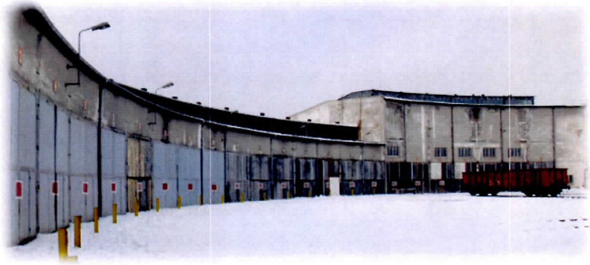
Fot. 3 – Nieużywana od 2010 roku, 24-stanowiskowa hala lokomotywni w Żaganiu
