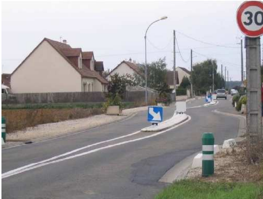
Rys. 33. Przewężenie na drodze – ograniczenie prędkości ruchu
