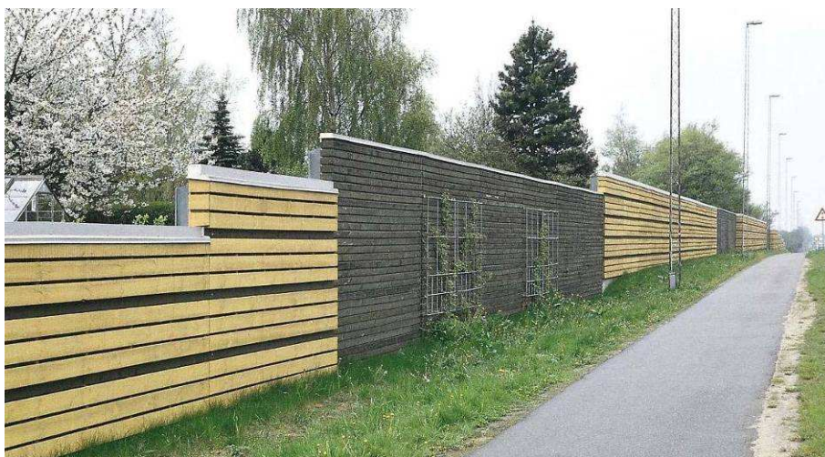
Rys. 41. Ekran przeciwhałasowy (drewniany)
