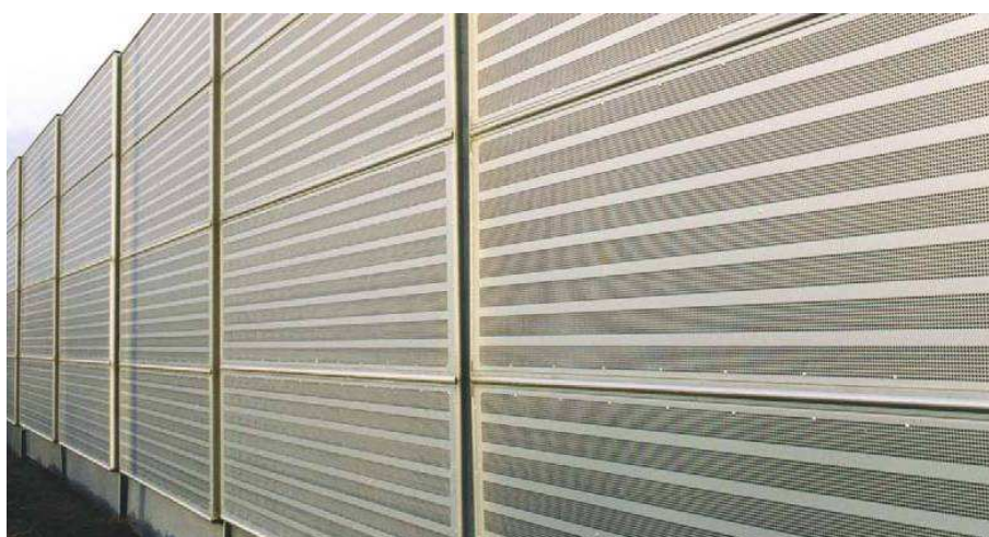
Rys. 43. Ekran przeciwhałasowy (dźwiękochłonny)
