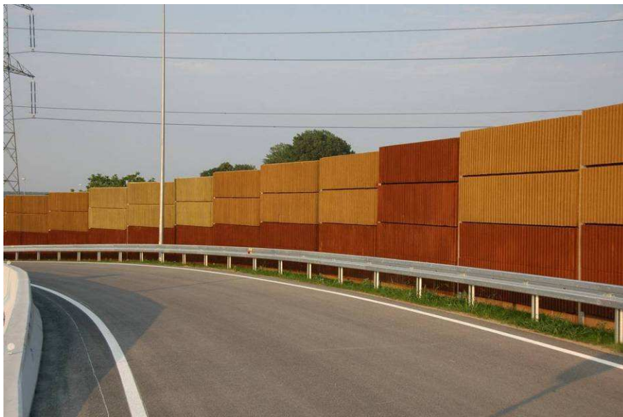
Rys. 40. Ekran przeciwhałasowy (betonowy)
