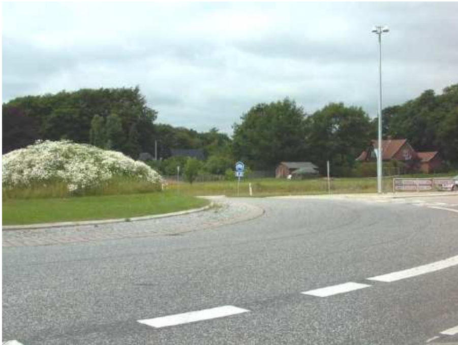
Rys. 38. Rondo, jako metoda redukcji hałasu drogowego
