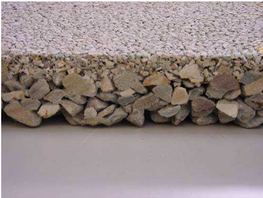
Rys. 36. Budowa nawierzchni dwuwarstwowej
