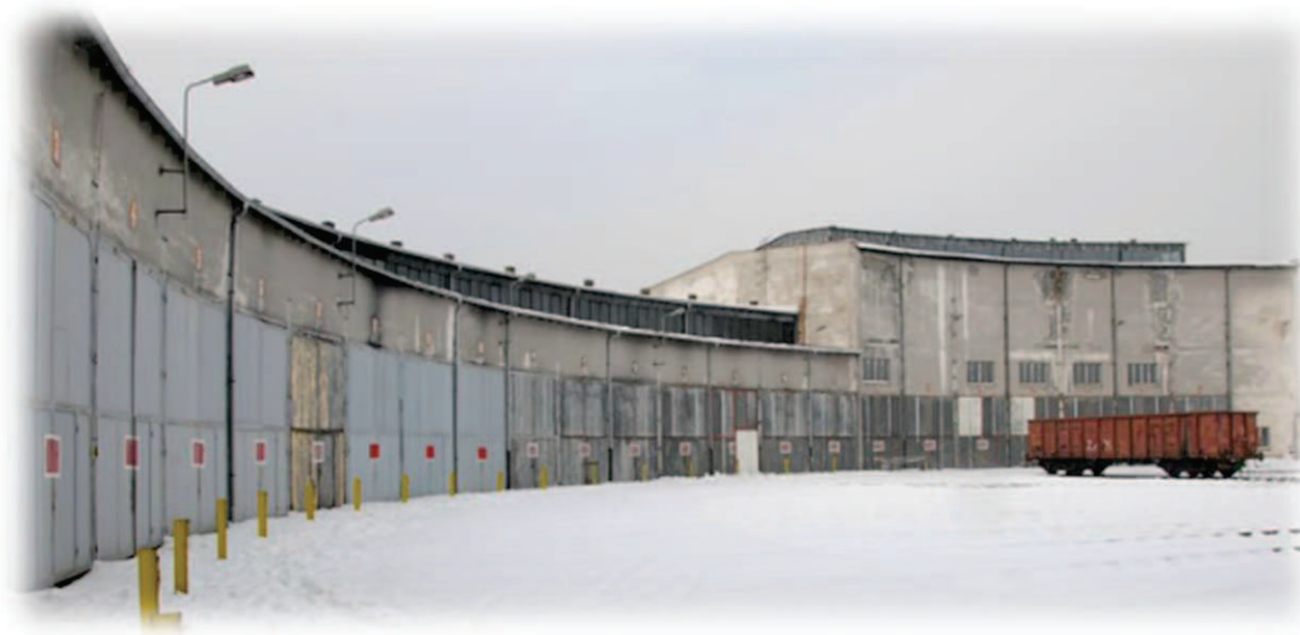
Fot. 3 – Nieużywana od 2010 roku, 24-stanowiskowa hala lokomotywni w Żaganiu
