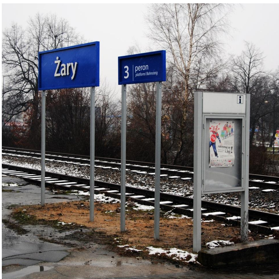
Fot. 7 - Widok standardowej tablicy informacyjnej z nazwą stacji, oznakowaniem peronu w języku polskim, niemieckim i angielskim oraz gablotą na umieszczenie informacji dla podróżnych
