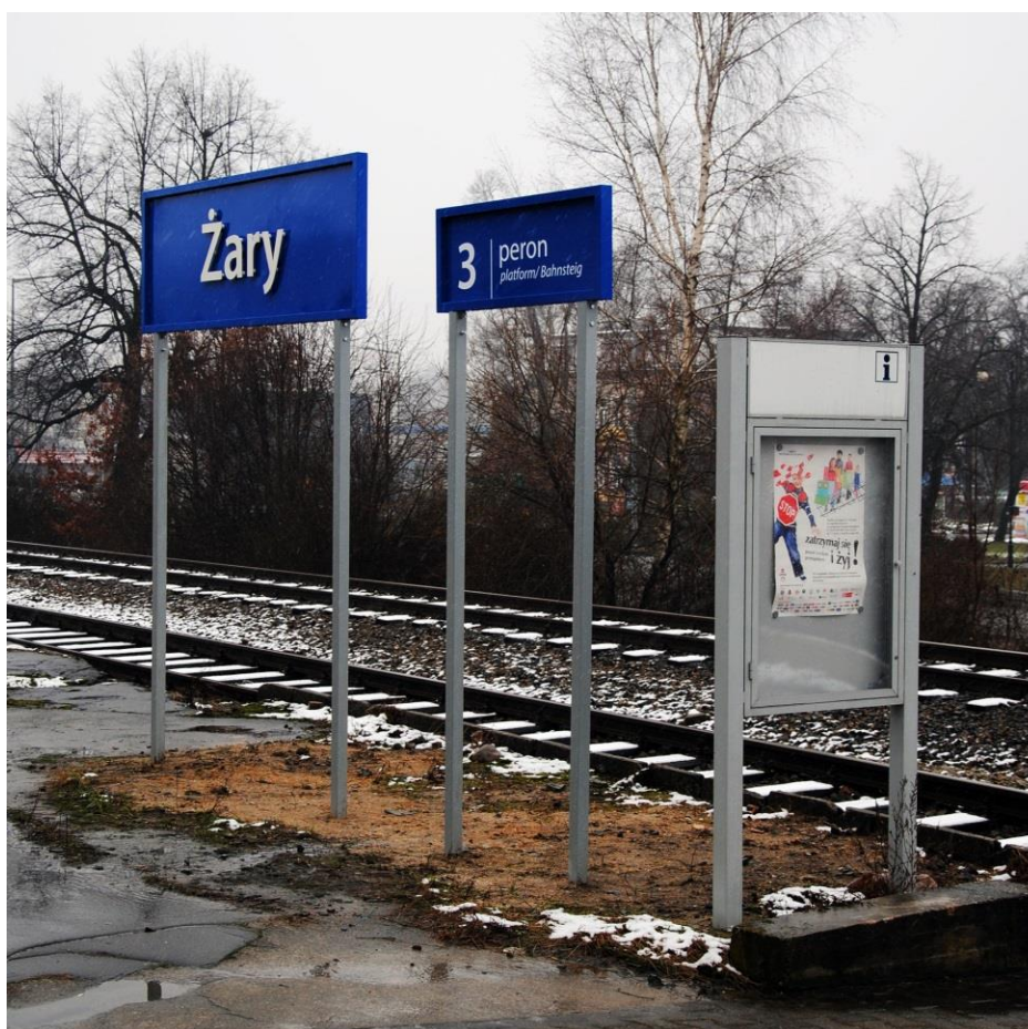
Fot. 7 - Widok standardowej tablicy informacyjnej z nazwą stacji, oznakowaniem peronu w języku polskim, niemieckim i angielskim oraz gablotą na umieszczanie informacji dla podróżnych
