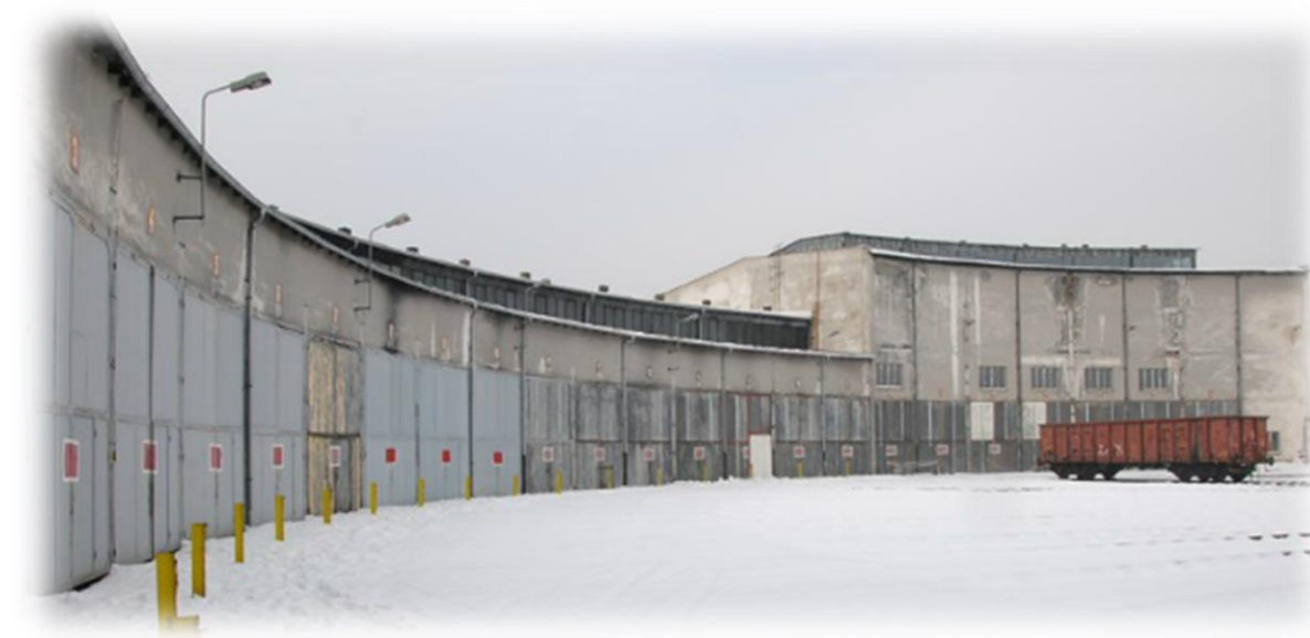
Fot. 4 – Nieużywana od 2010 roku, 24-stanowiskowa hala lokomotywni w Żaganiu
