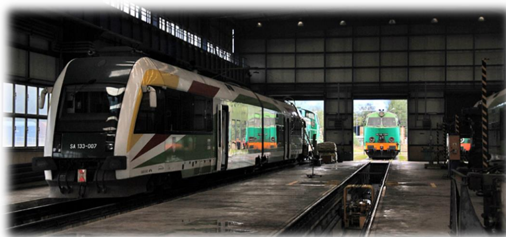
Fot. 3 – Wnętrze hali utrzymania taboru w Rzepinie
