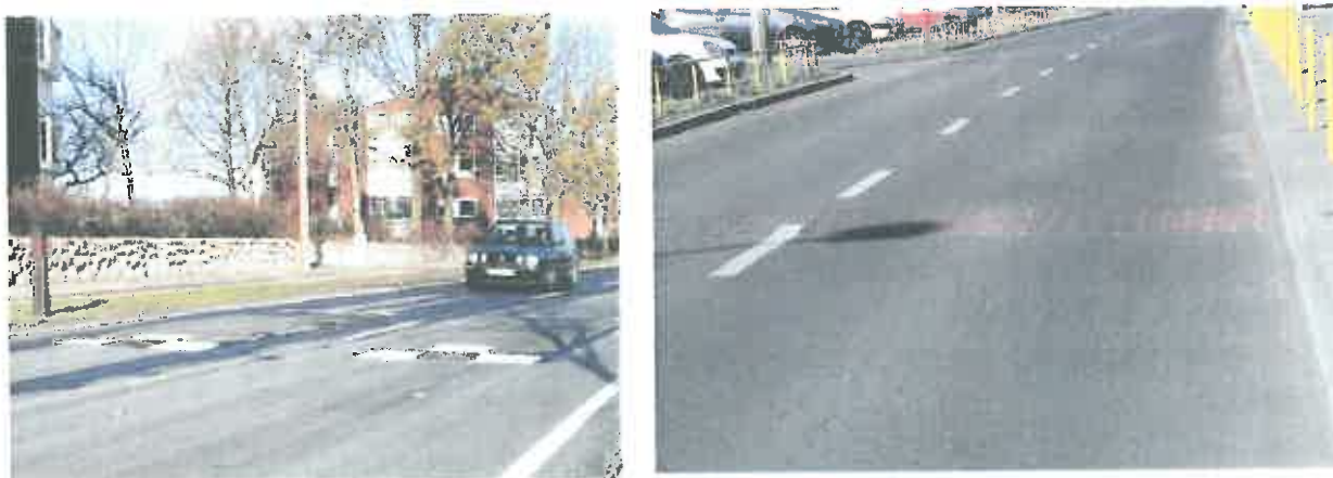
Rys. 32. Progi spowalniające na drodze – ograniczenie prędkości ruchu
