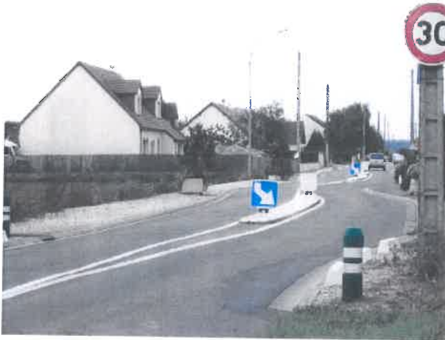
Rys. 33. Przewężenie na drodze – ograniczenie prędkości ruchu
