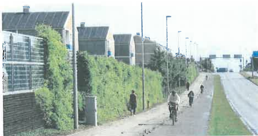
Rys. 42. Ekran przeciwhałasowy (przezroczysty, porośnięty roślinnością)
