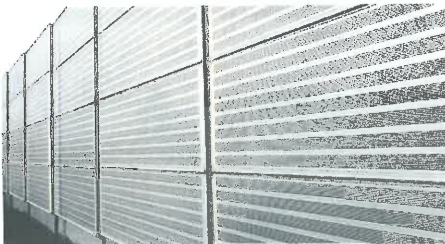
Rys. 43. Ekran przeciwhałasowy (dźwiękochłonny)
