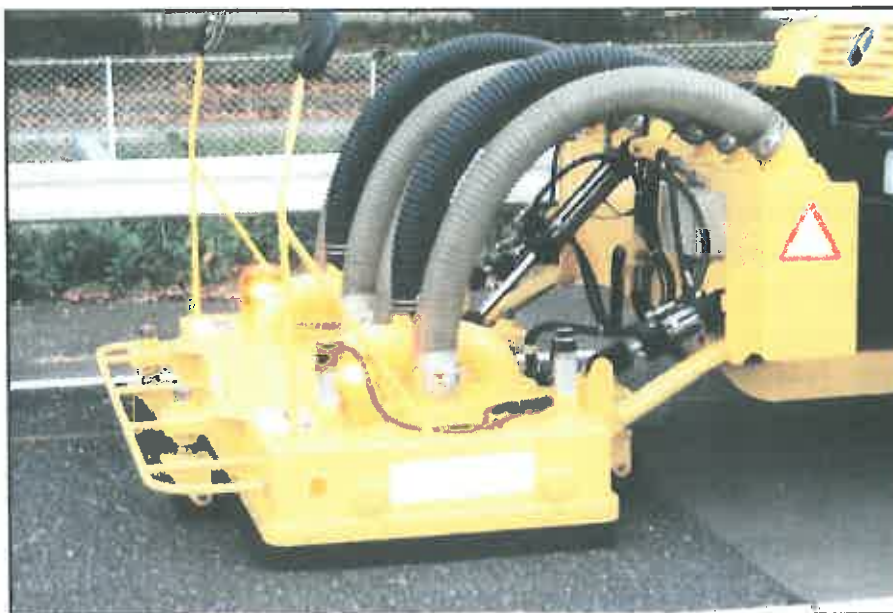
Rys. 47. Czyszczenie cichej nawierzchni drogowej przy wykorzystaniu sprężonego powietrza
