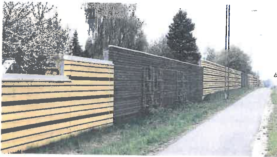
Rys. 41. Ekran przeciwhałasowy (drewniany)
