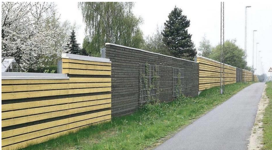
Rys. 15. Ekran przeciwhałasowy (drewniany)
