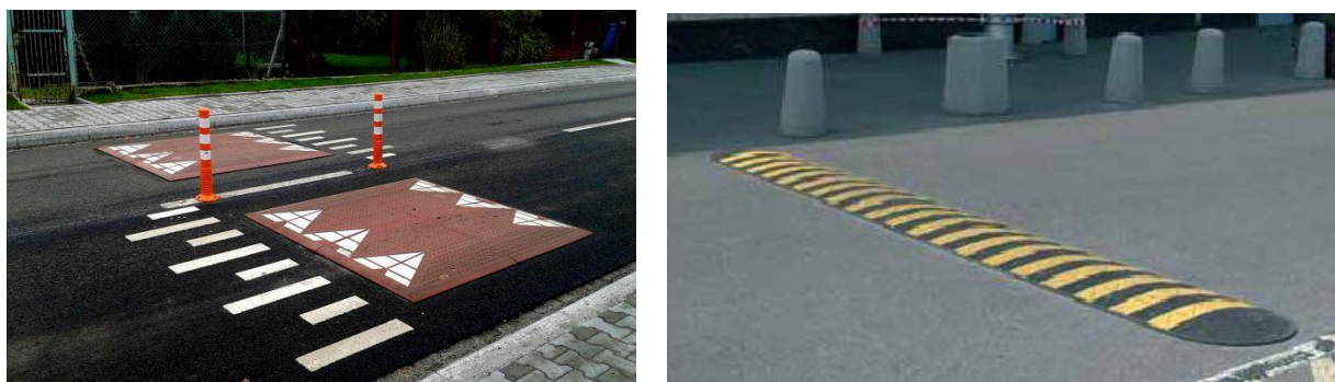
Rys. 6. Progi spowalniające na drodze - ograniczenie prędkości ruchu
