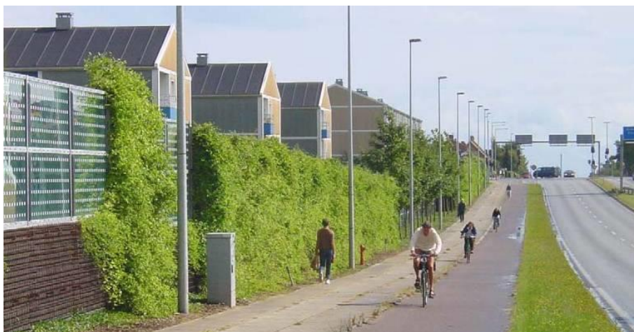
Rys. 16. Ekran przeciwhałasowy (przezroczysty, porośnięty roślinnością)
