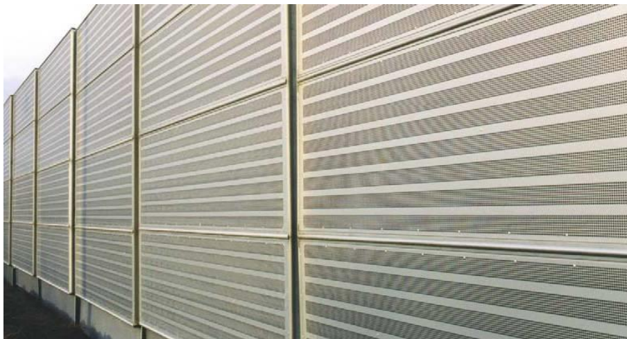
Rys. 17. Ekran przeciwhałasowy (dźwiękochłonny)
