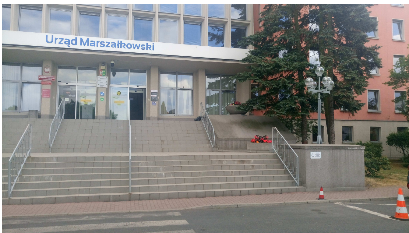
Fot. Widok elewacji frontowej.
