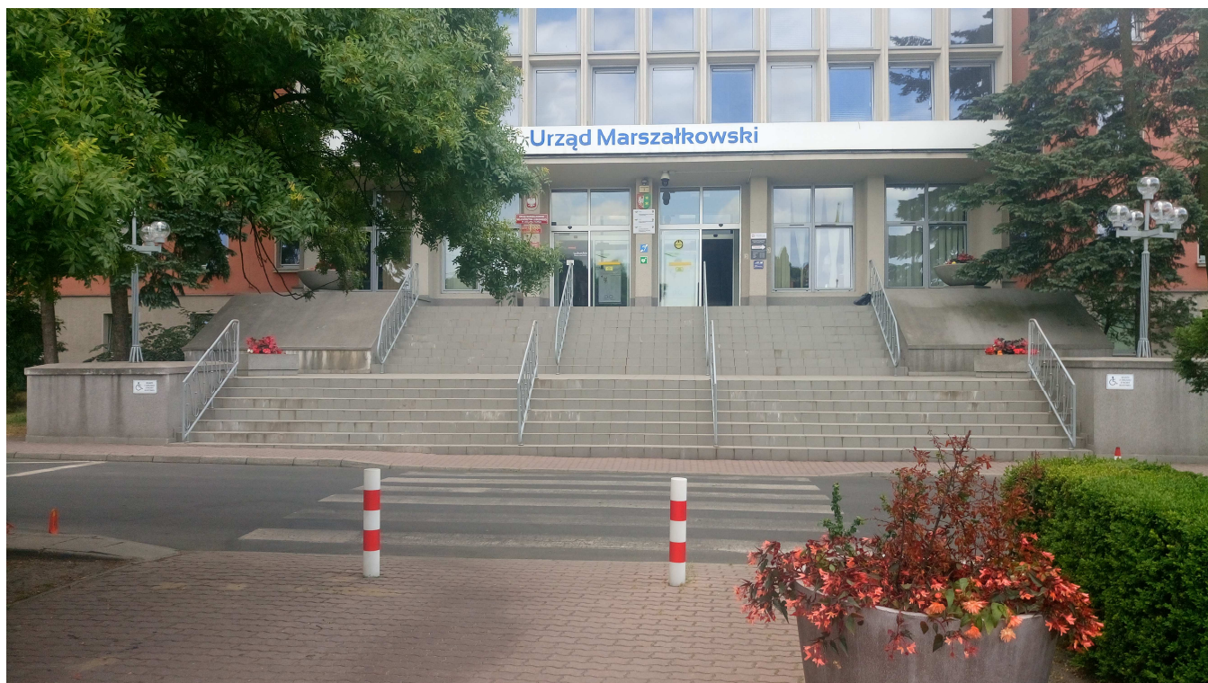
Fot. Widok elewacji frontowej.
