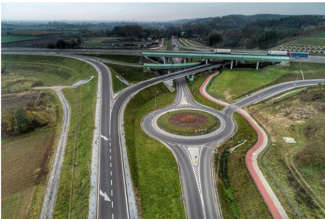
Fotografia 2. Węzeł Wieprzyce. Widoczne zabezpieczenia akustyczne (źródło: gorzowwielkopolski.naszemiasto.pl).
