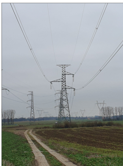
Słup Wy2 (przęsło Wy1-Wy2)
