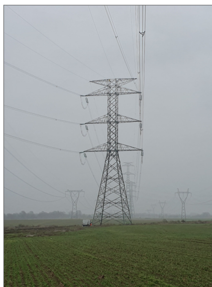
Słup Lu3 (przęsło Wy2-Lu3)
