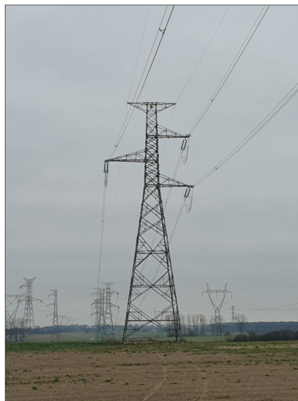
Słup Wy1 (przęsło Lu44-Wy1)
