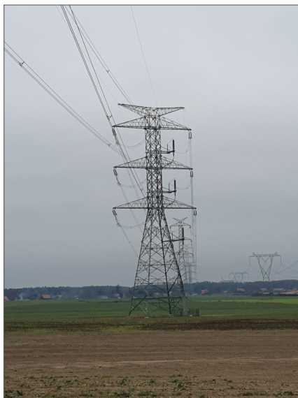
Słup Lu44 (przęsło Lu44-Wy1)
