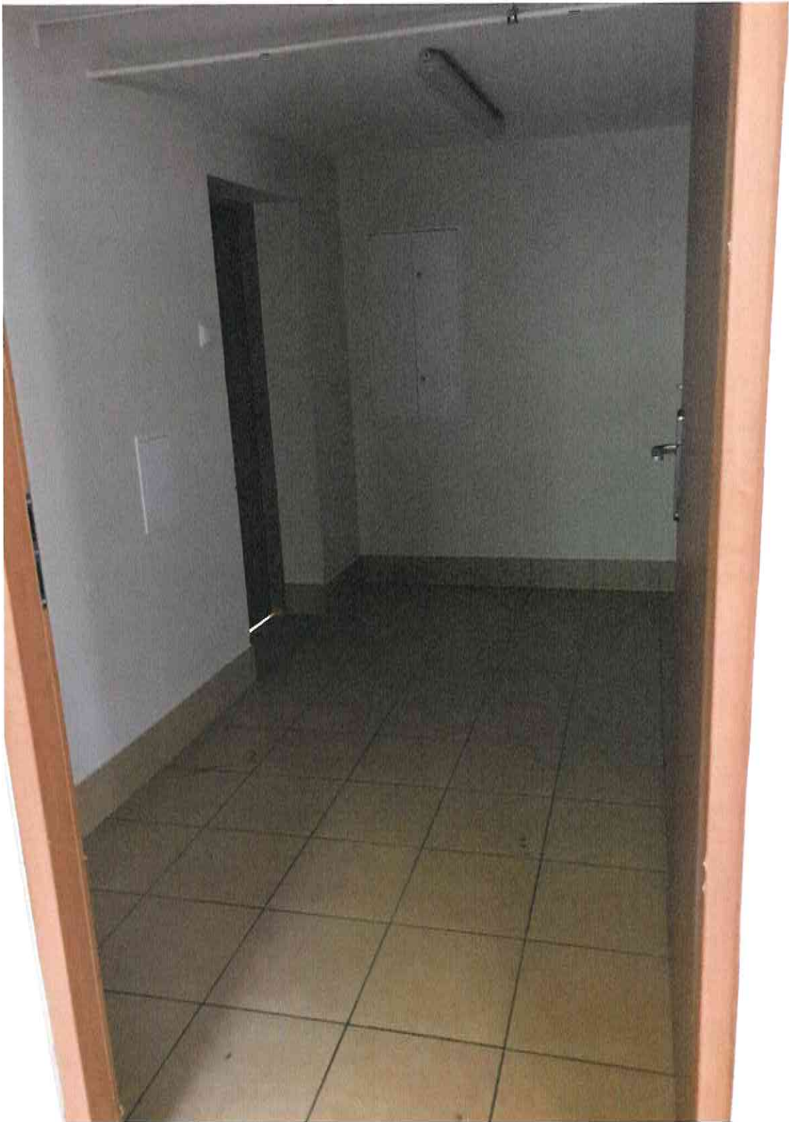
Korytarz przy WC dla personelu i zapleczu
