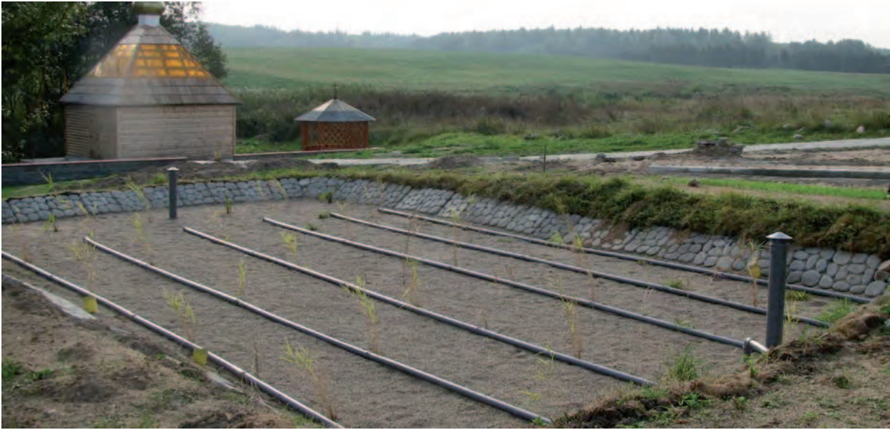
Fot. 11. Oczyszczalnia hydrofitowa w fazie rozruchu (zdjęcie: Michał Hawryłyszyn)
