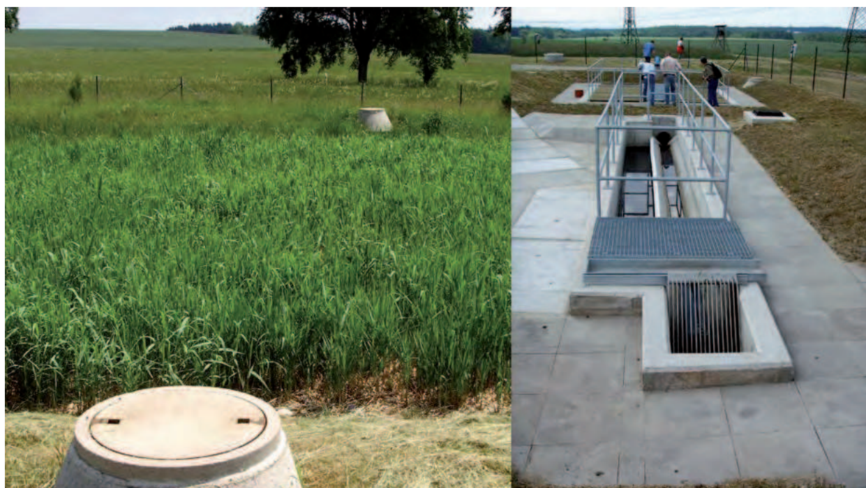
Fot. 9. Przykład oczyszczalni hydrofitowej obsługującej wieś – Czechy (zdjęcie: Wojciech Dąbrowski)
