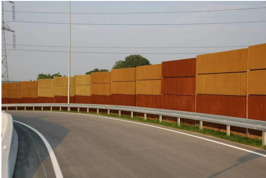
Rys. 14. Ekran przeciwhałasowy (betonowy)
