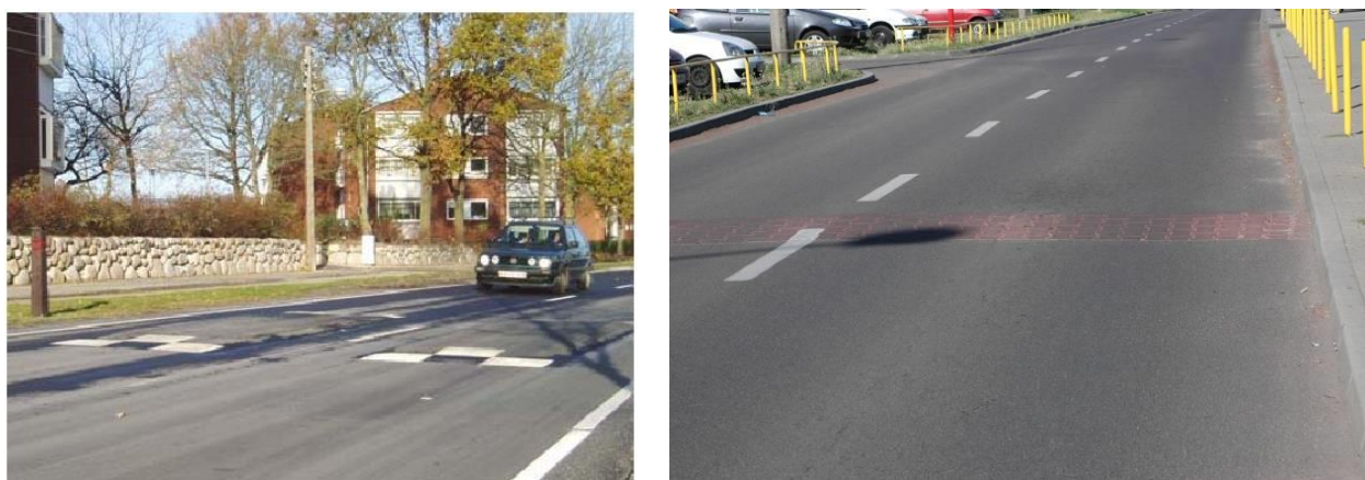
Rys. 6. Progi spowalniające na drodze – ograniczenie prędkości ruchu
