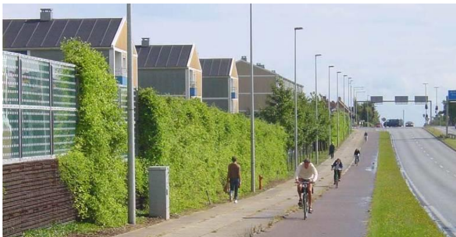
Rys. 16. Ekran przeciwhałasowy (przezroczysty, porośnięty roślinnością)
