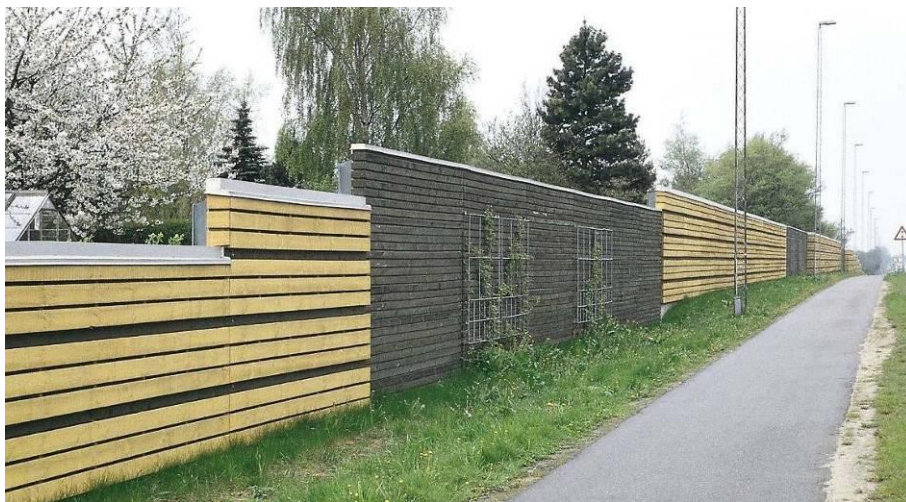
Rys. 15. Ekran przeciwhałasowy (drewniany)
