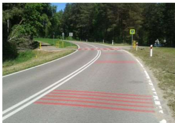
Fotografie 17 Ograniczenie prędkości oraz pasy hamowania optycznego przed przejazdem dla rowerów poza obszarem zabudowanym.
