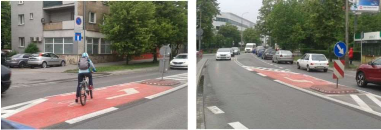
Fotografie 22 Azyl umożliwiający rowerzyście bezpieczne wykonanie skrętu w lewo.
