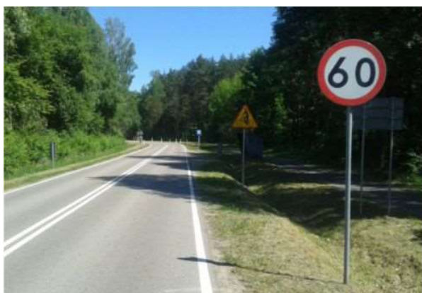
Fotografie 17 Ograniczenie prędkości oraz pasy hamowania optycznego przed przejazdem dla rowerów poza obszarem zabudowanym.
