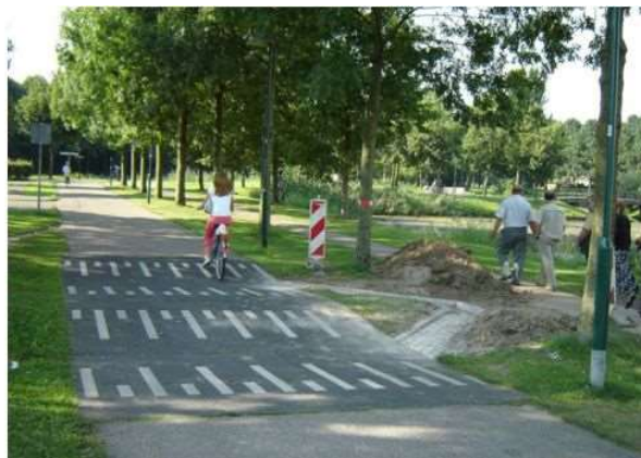
Fotografie 14 Rozwiązania uspokajające ruch rowerowy; od lewej: odgięcie toru ruchu rowerów przed wlotem na skrzyżowanie; zespół progów zwalniających, tzw. fala .
