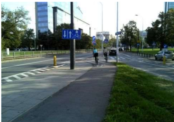
Fotografie 21 Zjazd z jednokierunkowej drogi dla rowerów na pas ruchu dla rowerów z zastosowaniem wyspy ze słupkiem przeszkodowym U-5a.
