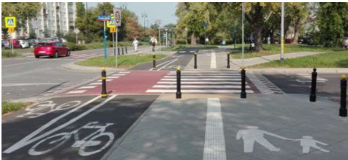
Fotografie 18 Wyniesiony przejazd rowerowy wraz z przejściem dla pieszych w miejscu przecięcia drogi dla rowerów z podporządkowaną drogą poprzeczną.
