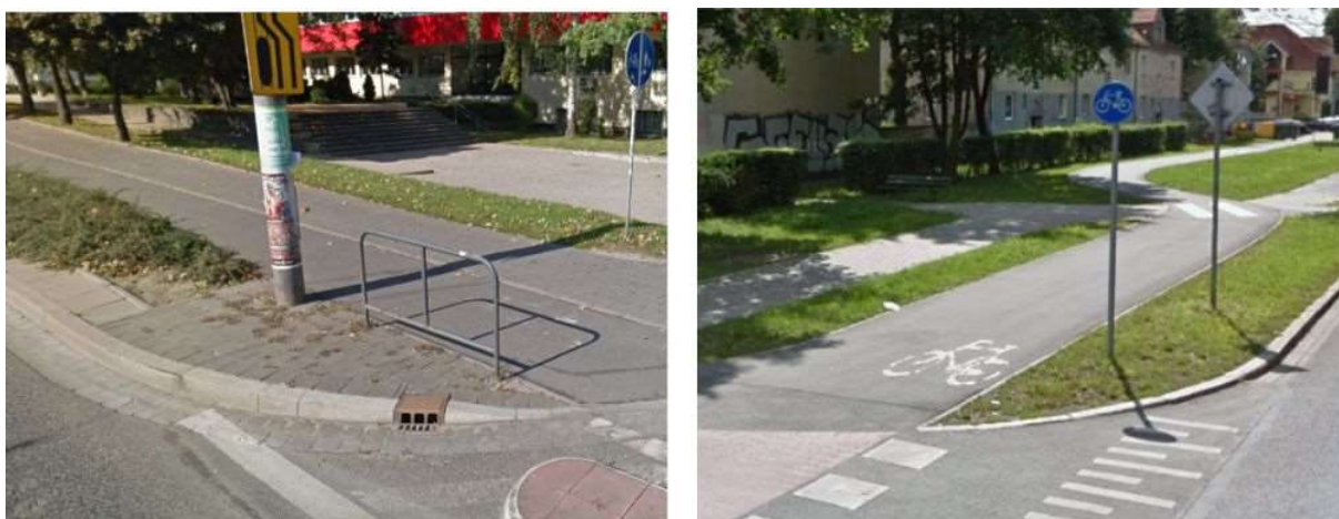
Fotografie 7 Przerwanie ciągłości krawężnika w miejscu przejazdu dla rowerów poprzez stopniowe obniżenie.
