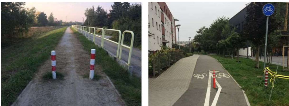
Fotografie 26 Elementy odblaskowe na słupach w ciągu dróg dla rowerów.
