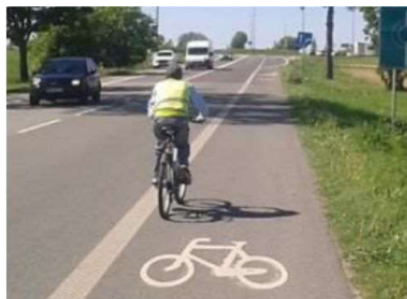
Fotografie 9 Jednostronny, jednokierunkowy pas ruchu dla rowerów w obszarze zabudowanym i poza obszarem zabudowanym przy ograniczeniu prędkości do 60 km/h.
