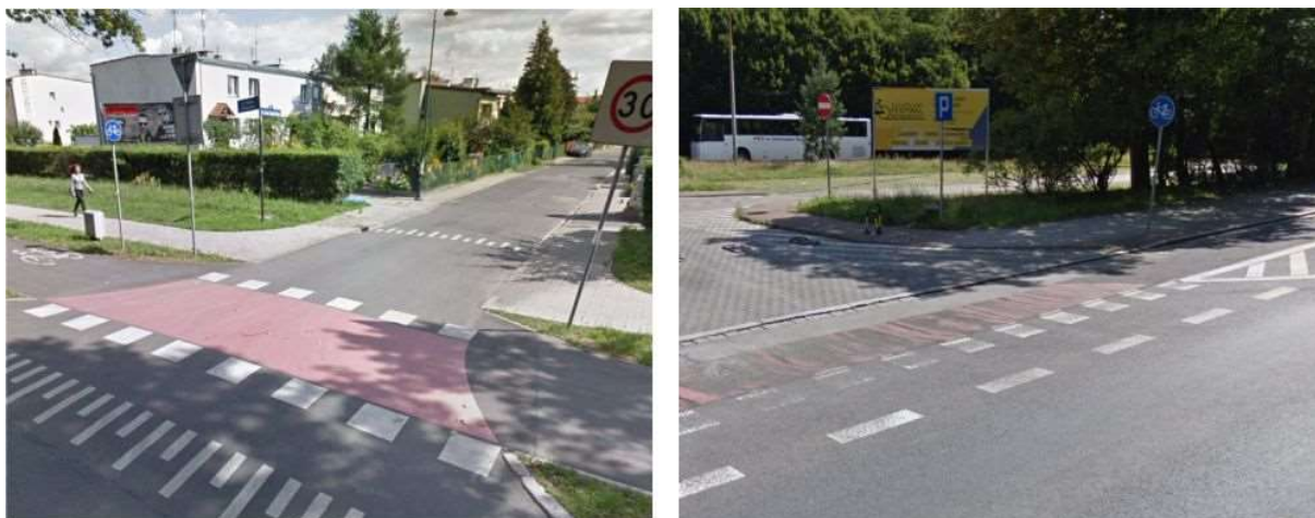
Fotografie 8 Przykładowe rozwiązania podkreślające pierwszeństwo rowerzystów na przecięciach i zjazdach dróg rowerowych i publicznych.
