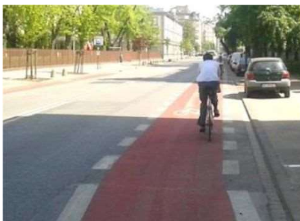
Fotografie 9 Jednostronny, jednokierunkowy pas ruchu dla rowerów w obszarze zabudowanym i poza obszarem zabudowanym przy ograniczeniu prędkości do 60 km/h.
